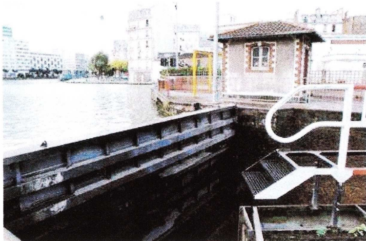
Batardeau amont, grand sas de la première écluse
