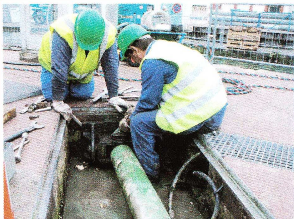
Thierry Frison, compagnon hydraulicien et Guy Grimault chef de chantier chez Hydraflex
