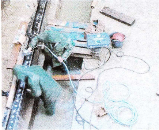
Fixation d'un joint de porte sous la pluie
